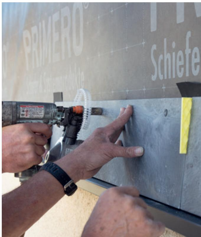
Der **PRIMERO-FIXX<sup>®</sup>-Druckluftnagler** bietet durch seine ausgewogene Konstruktion und das geringe Gewicht (ca. 1.220 g) eine bequeme und praktische Handhabung.
